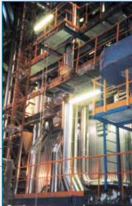
En Estonia, la CFI prestó apoyo a Horizon Pulp and Paper para la instalación de una nueva caldera de recuperación que permitió mejorar la eficiencia, las emisiones y la seguridad.
