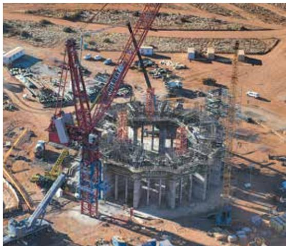
上图：国际金融公司正在支持修建南非的第一座聚光型太阳能电站，这个电站利用镜面来反射和汇聚太阳光以加热蒸汽，再用蒸汽推动汽轮机发电。
