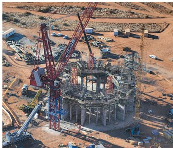
*Photo ci-dessus* : IFC finance la construction de la première centrale d'énergie solaire concentrée d'Afrique du Sud, qui utilisera des miroirs pour refléter et concentrer les rayons du soleil afin de chauffer la vapeur entraînant les turbines.
